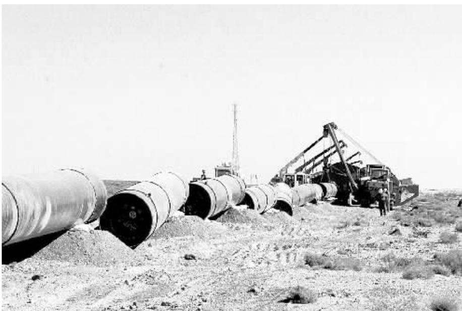
10月16日,在甘肃玉门市清泉镇境内的戈壁滩上,大庆油田管道公司建设者正在进行管道吊装焊接。近日开工的西气东输三线管道工程正在加紧建设。据了解,这项工程西起新疆霍尔果斯,东至福建省福州市,项目建设总投资1250亿元人民币,干支线沿线经过新疆、甘肃、河南等地,干线、支线总长度为7378公里,设计年输气量300亿立方米。
