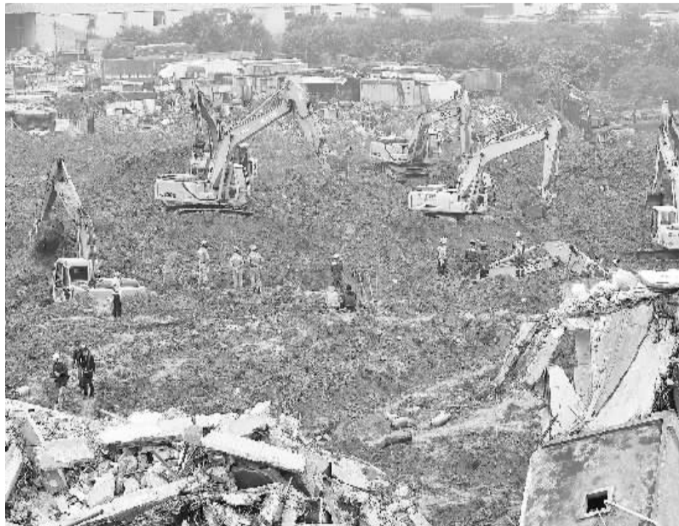
12月21日,救援人员在深圳山体滑坡现场搜救。新华社
