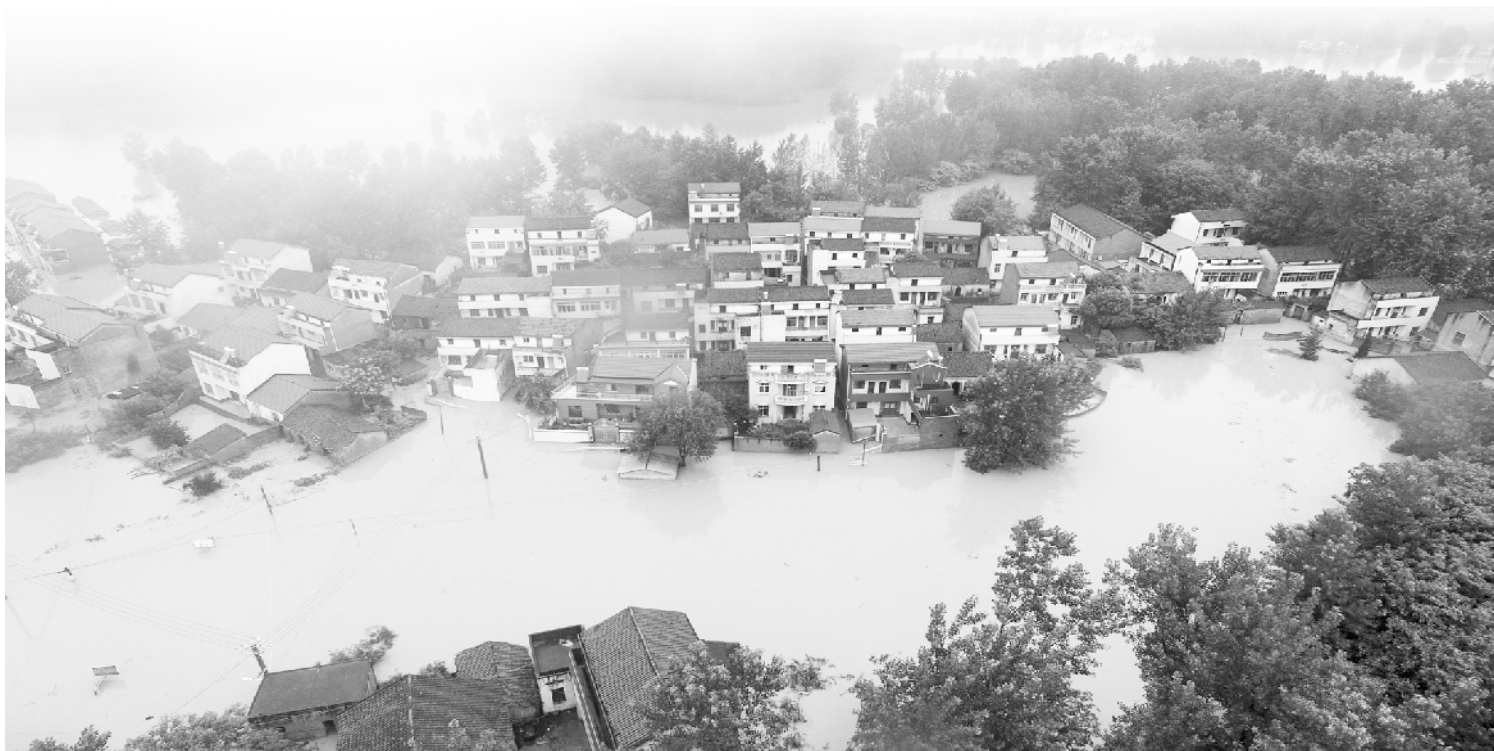
7月1日晚,湖北武汉新洲区举水河发生特大洪水后被淹的村庄。新华社
