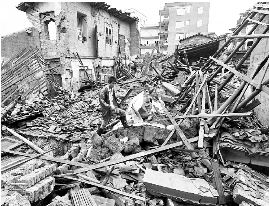
7月9日,莆田市新度镇凌厝村受灾村民在自己倒塌的房屋上清理杂物。新华社
