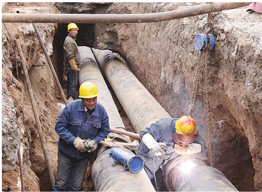
孔明路热力管网施工现场 通讯员 郑雨 摄
