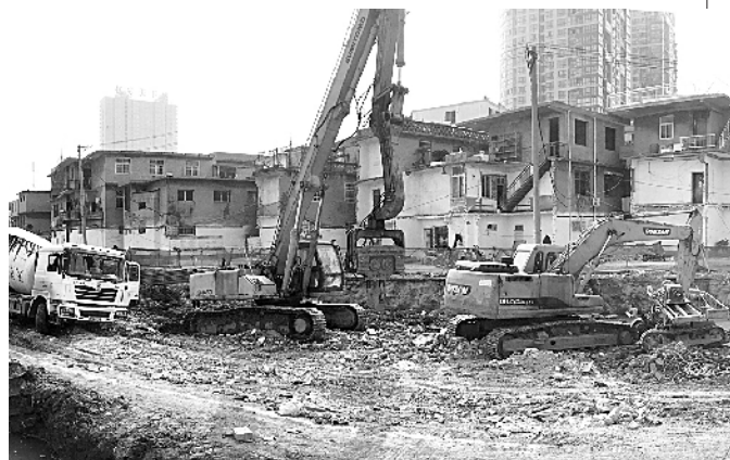
梅溪河治理施工现场
