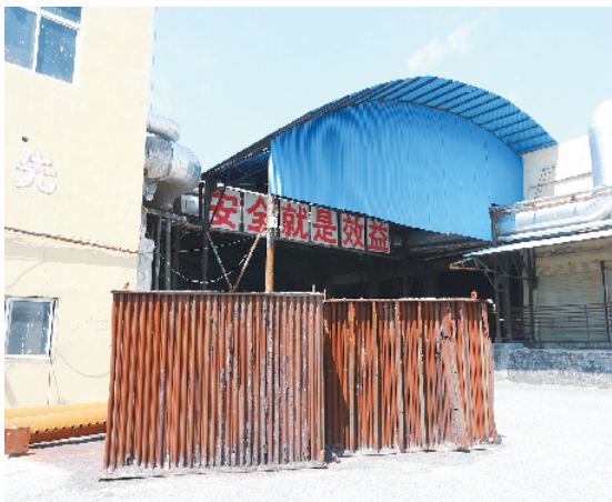
拆除的旧设备
