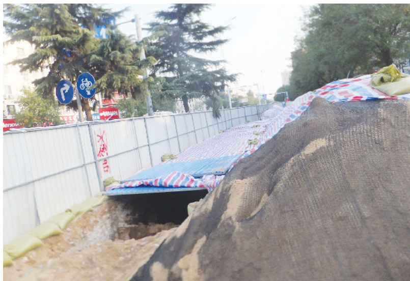
工业南路上正在施工的供暖管网
