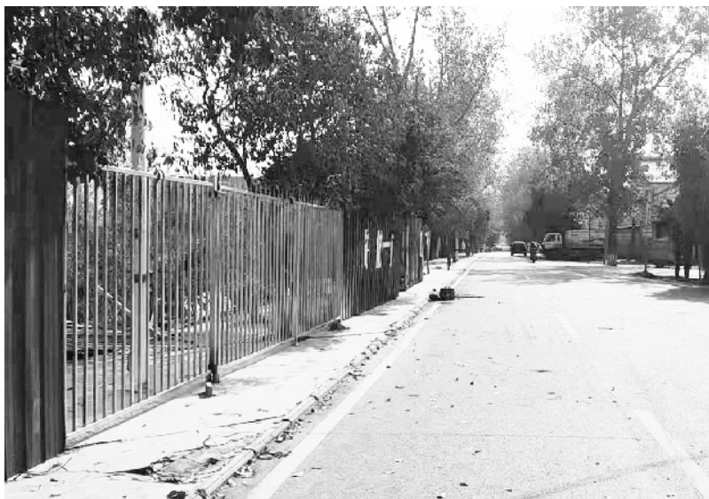
拆除拦挡后的道路 本报记者 杨长坡 摄
