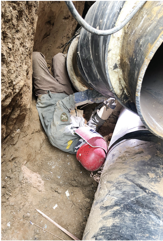
工人加紧施工 本报记者 于晓霞 摄
