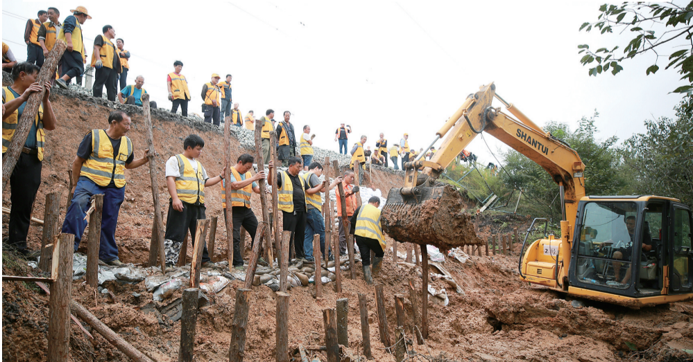
南阳工务段组织人员进行抢险整治工作。通讯员 张中海 摄
