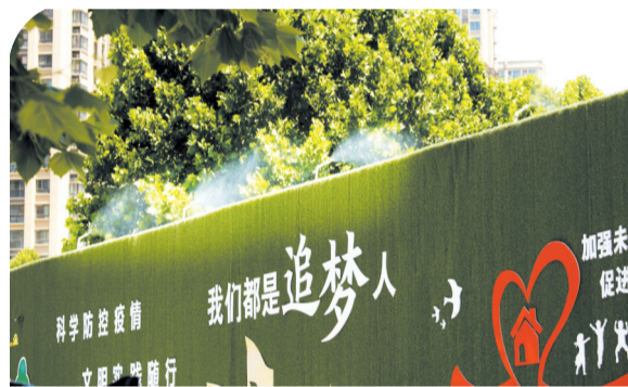
建筑工地坚持“绿色施工”。
