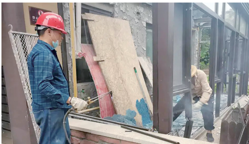
拆除现场 本报记者 于欢 摄
