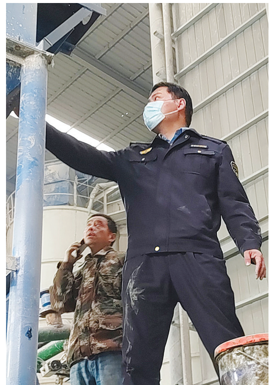
执法人员上门为企业检查治污设施异常情况。
