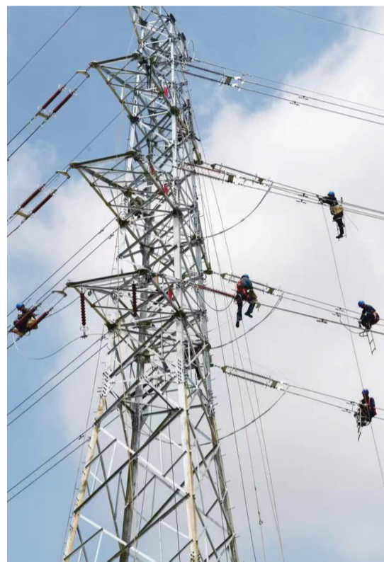
加紧施工保供电。通讯员 王涛 摄
