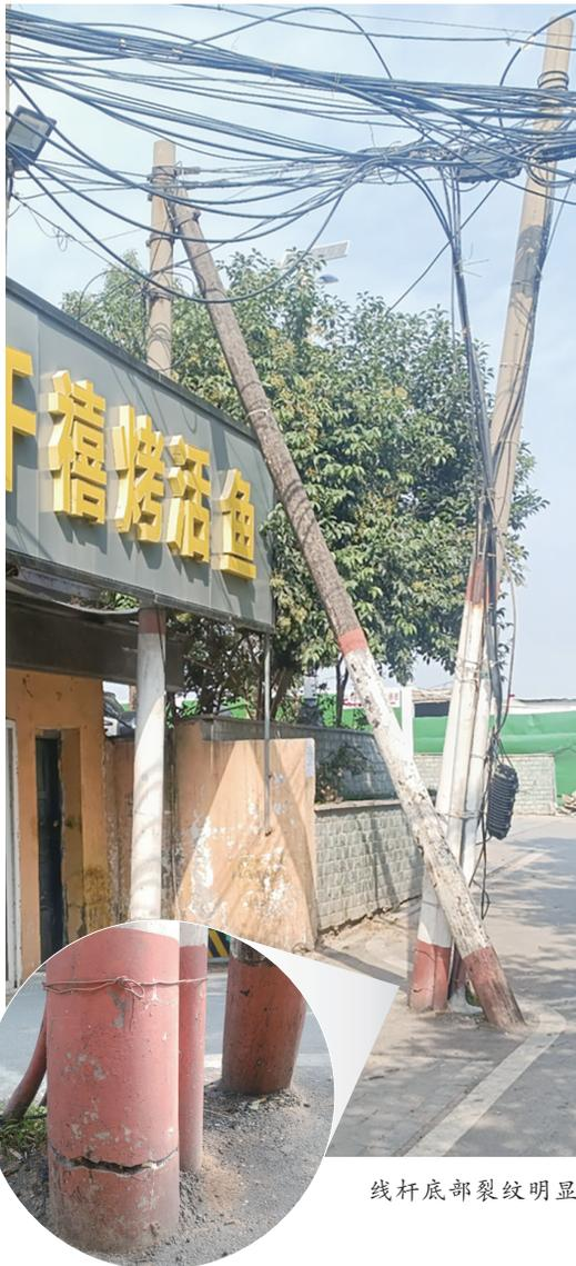
线杆底部裂纹明显
