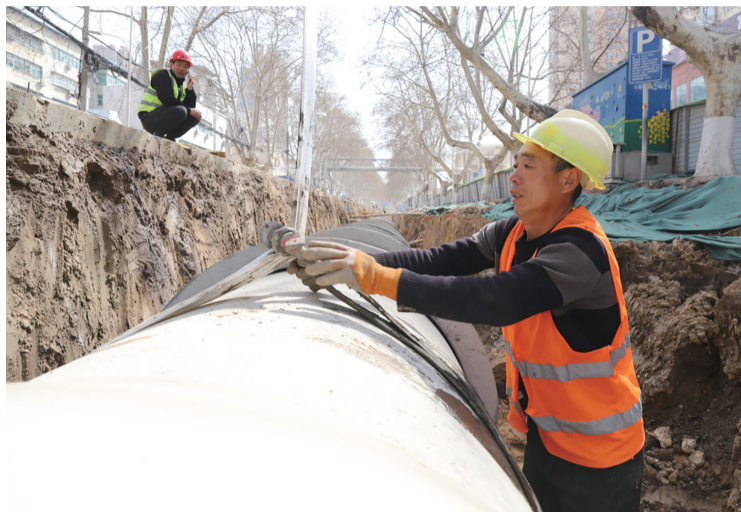
铺设新的雨水管道 本报记者 周梦 摄
