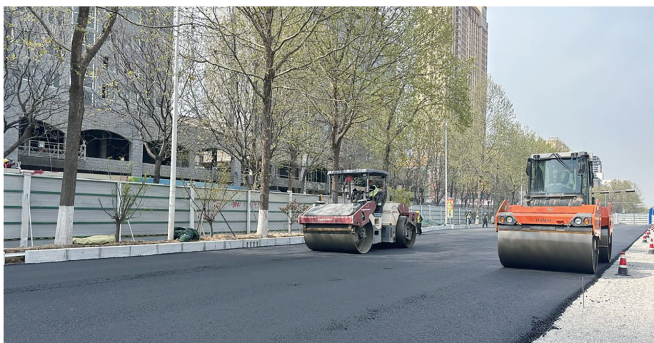
施工现场 全媒体记者 谢项伟 摄
