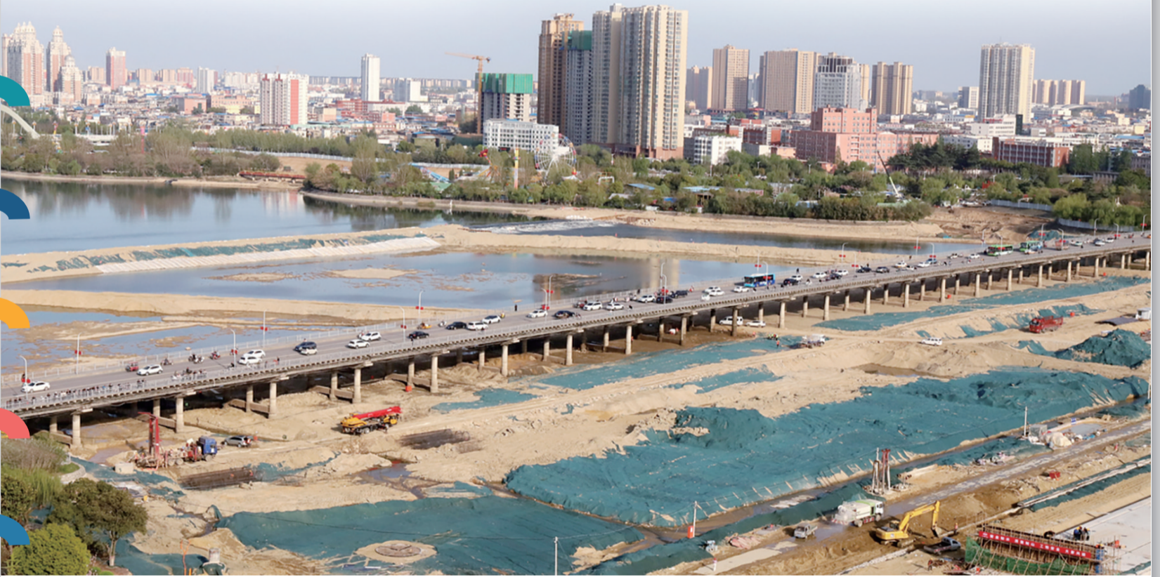
施工现场 本报记者 周梦 张玲 摄
