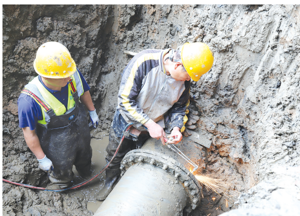
拆卸受损螺栓
