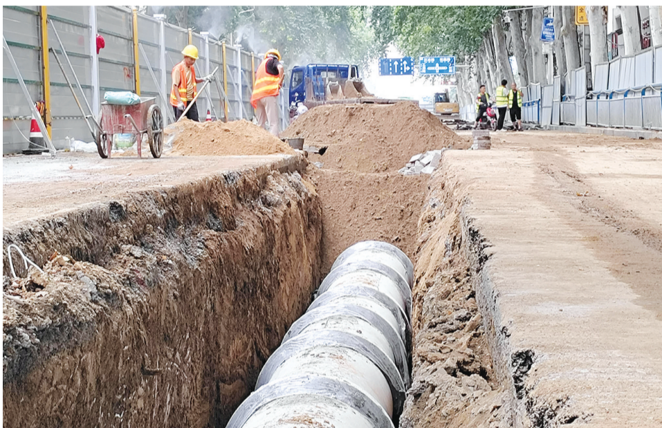
铺设排水管道 全媒体记者 谢项伟 谢康 摄
