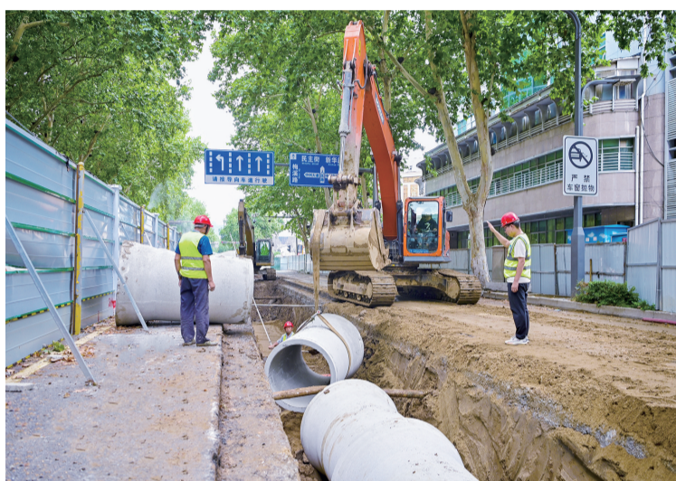
人民路排水防涝项目施工现场 本报记者 张峰 张兰 摄
