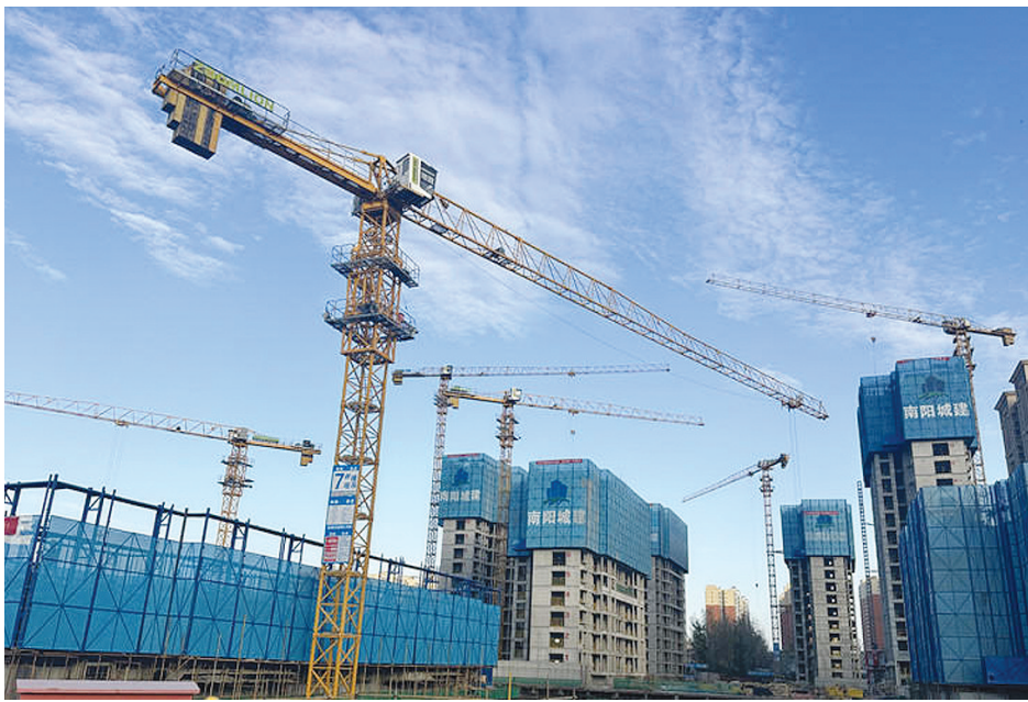
施工现场 全媒体记者 马新峰 洪塔 摄
