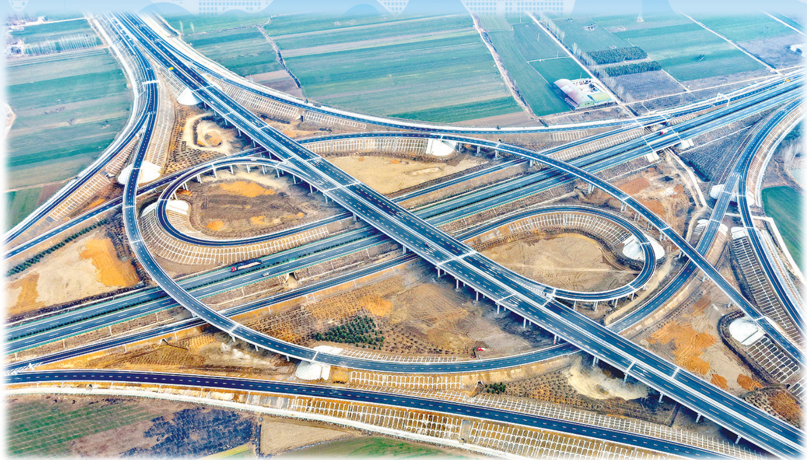
12月28日上午10时,S49焦唐高速南阳段通车试运营。图为焦唐高速与商南高速交通枢纽处。③④ 本报记者 张峰 摄
