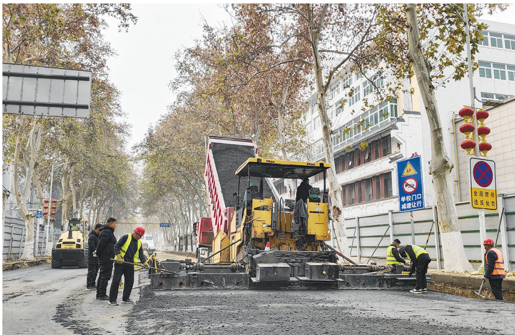
施工现场 全媒体记者 谢项伟 摄
