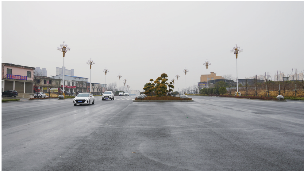
平整宽阔的光武大道(麒麟路至312国道段) 全媒体记者 赵洋 张雪飞 摄
