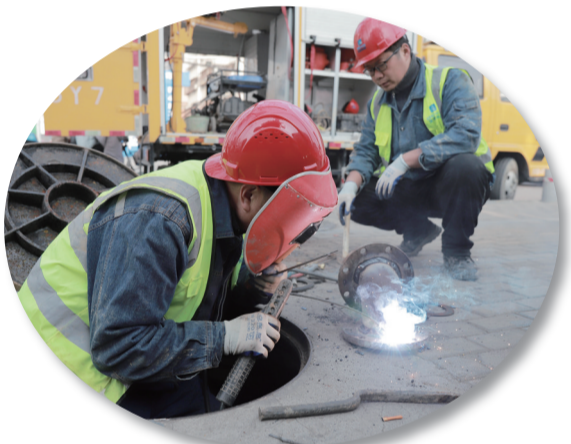
工农路上,水务集团工人检修供水管道
