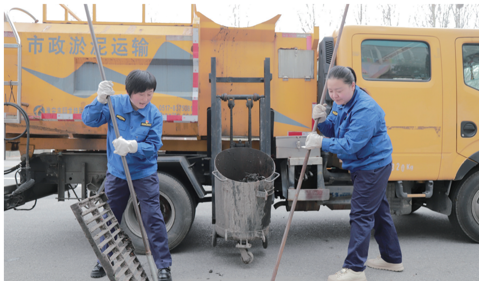
女子疏浚班清掏窨井
