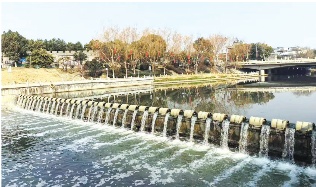
调换水后的温凉河入河口 本报记者 李辉 通讯员 孟刚 摄
