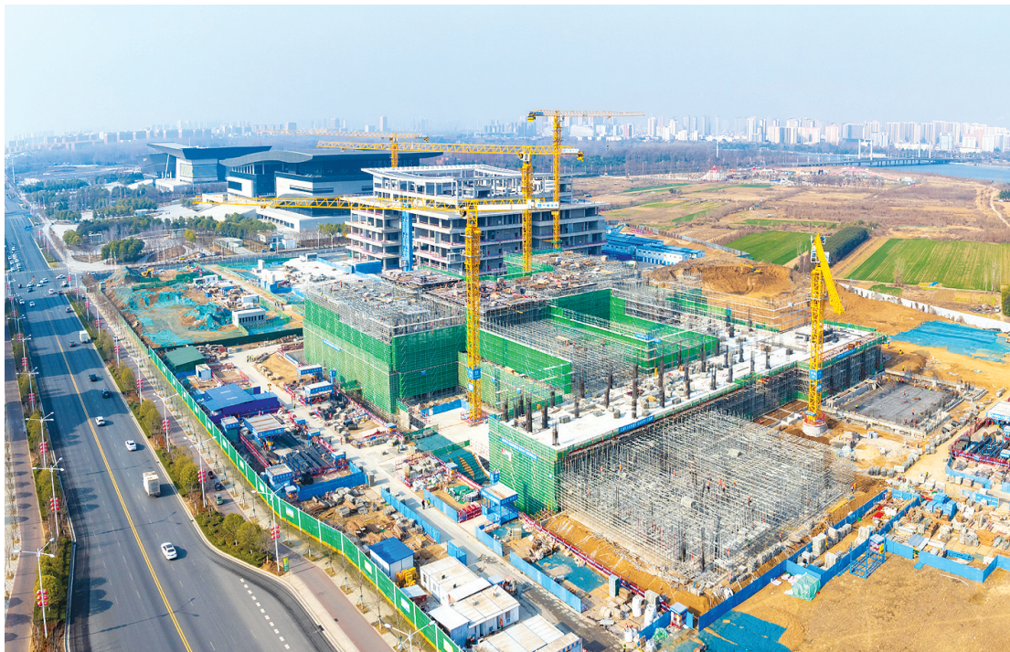
施工现场鸟瞰图 全媒体记者 赵洋 谢康 摄
