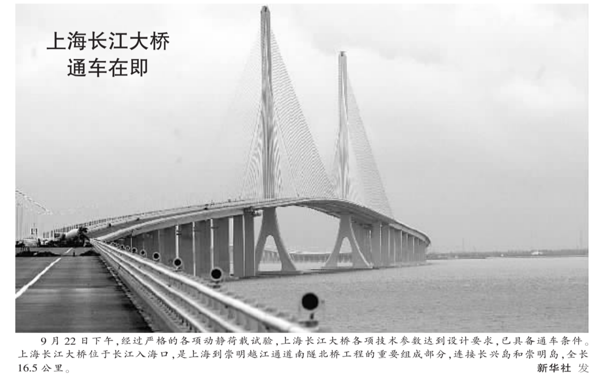
9月22日下午，经过严格的各项动静荷载试验，上海长江大桥各项技术参数达到设计要求，已具备通车条件。上海长江大桥位于长江入海口，是上海到崇明越江通道南隧北桥工程的重要组成部分，连接长兴岛和崇明岛，全长16.5公里。
