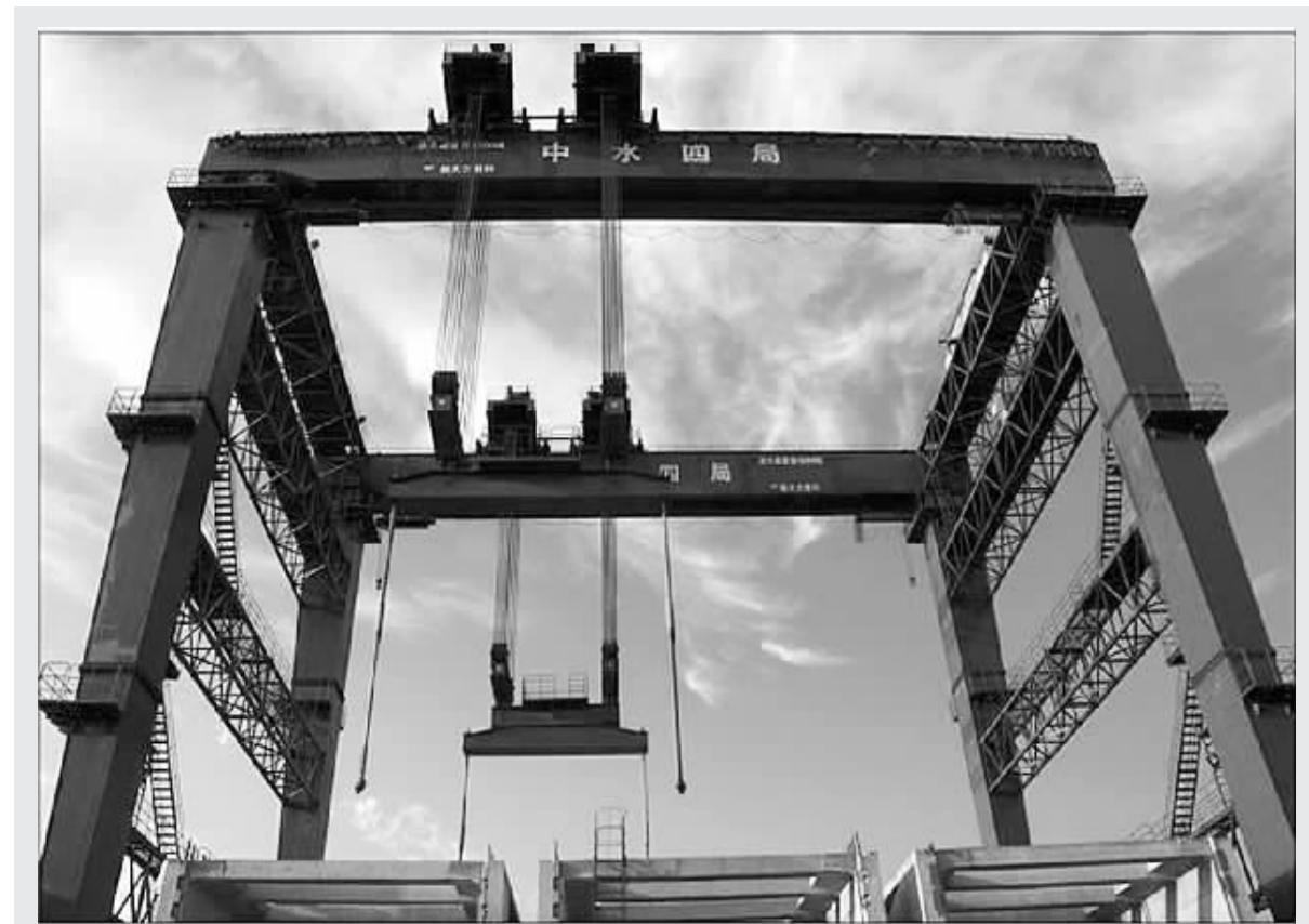
建设中的沙河斗槽工程
