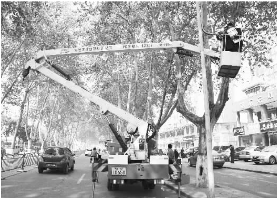
施工人员正在安装LED灯 本报记者 张晓彭 摄
